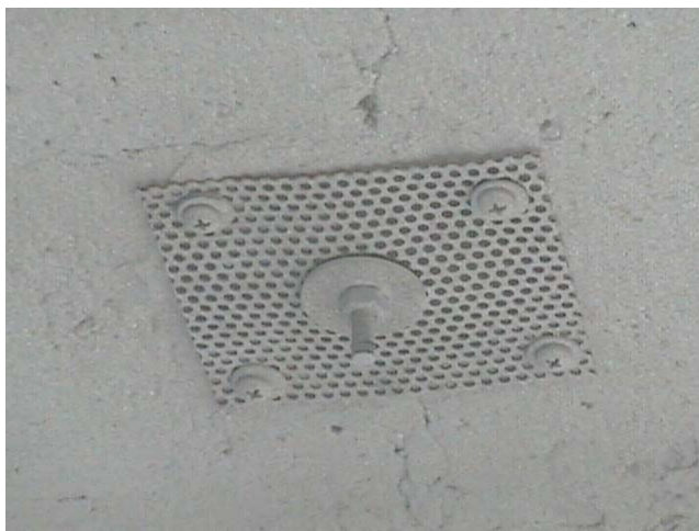
Detalle de conexión del ánodo
